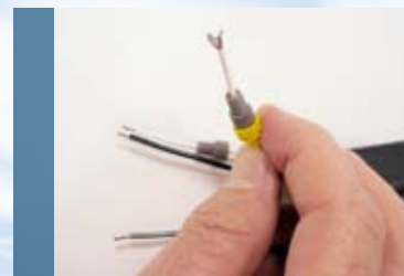
6. Prepare a ponta dos fios para conexão.
